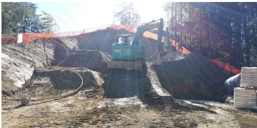
Abbildung 4: Erdarbeiten im Zuge der Mastfundierung
